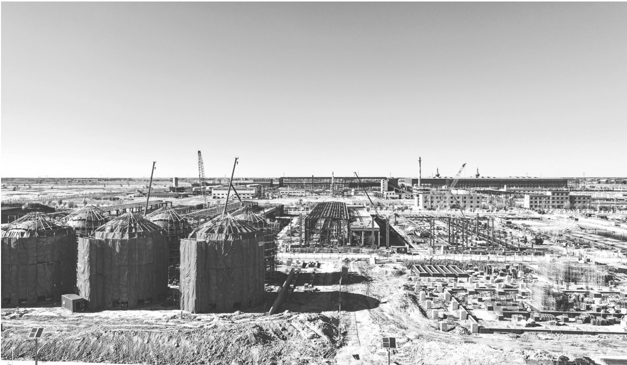
大安风光制绿氢合成氨一体化示范项目是大安市招商引资项目,分别为制氢合成氨、风电、光伏三部分建设,其中制氢合成氨部分建设位于吉林西部(大安)清洁能源化工产业园。日前综合办公楼土建施工完成,碱液制氢厂房已完成总工程量的90%,中心控制室、危废库完成基础建设。 于淼 记者 李晓明 摄
