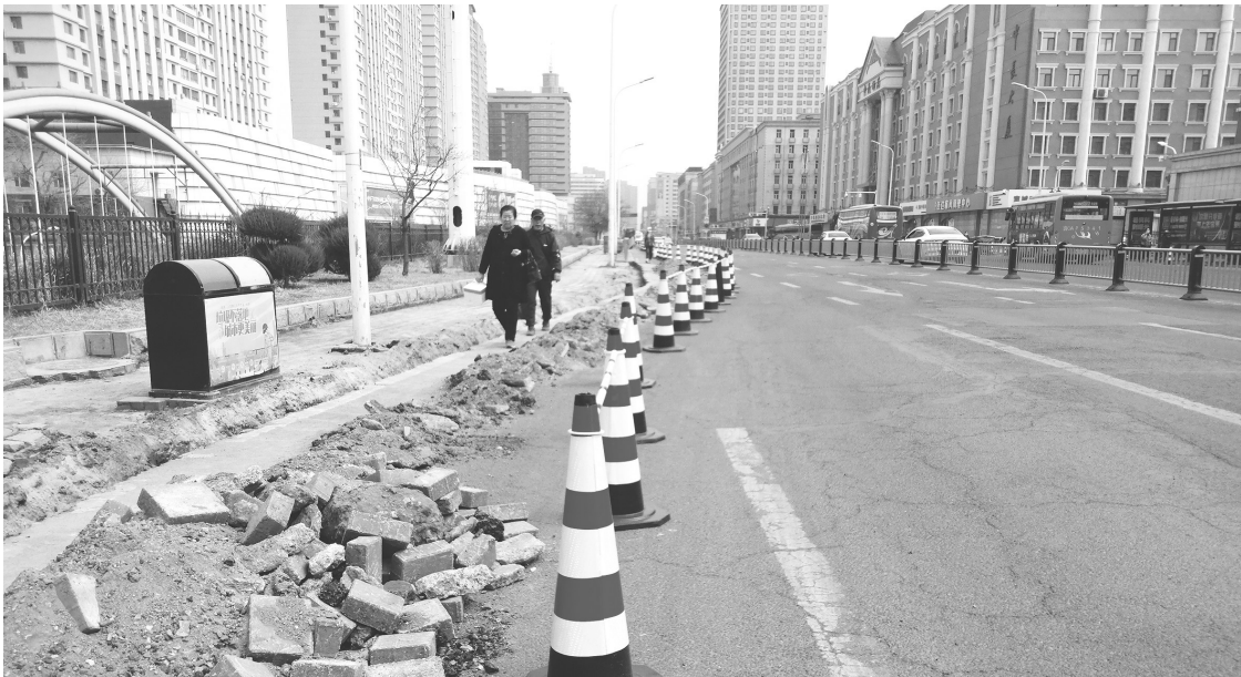
沿线正在施工改造 城市晚报全媒体记者 刘佳雪 摄
