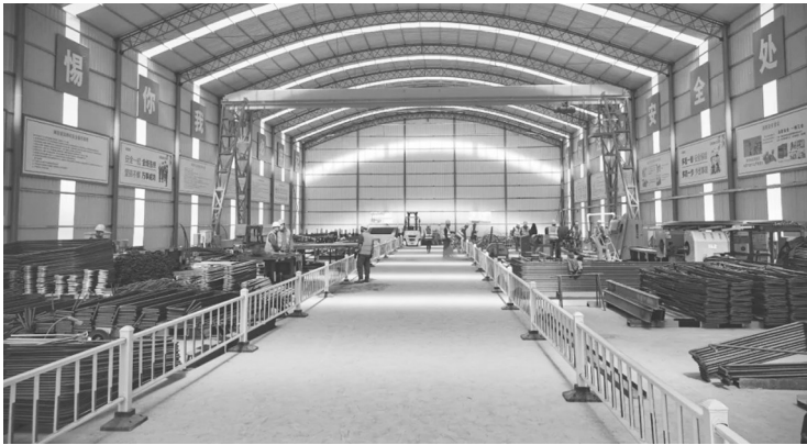
钢筋绑扎作业 吉高集团供图
