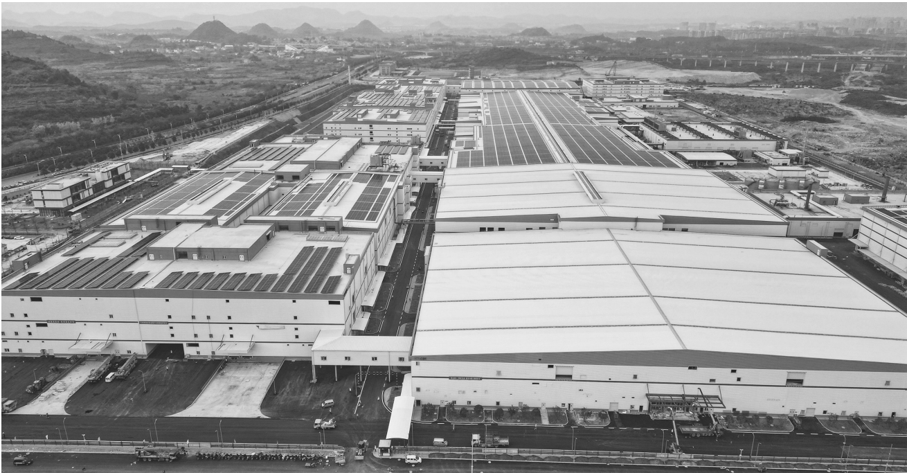
宁德时代(贵州)新能源动力及储能电池生产制造基地(2023年10月19日摄,无人机照片)。新华社记者 向定杰 摄
