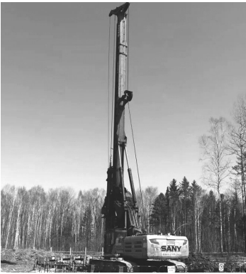
打桩机进行桩基施工
