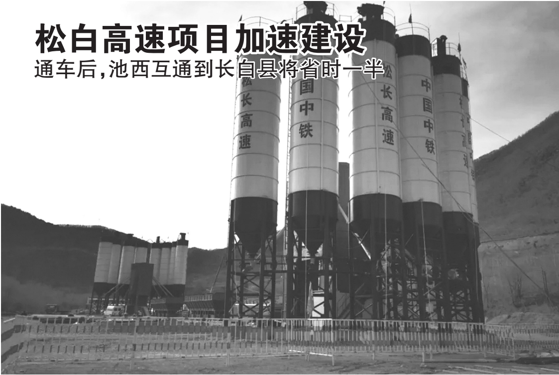
项目工地现场 本组图片 省交通宣传中心供图
