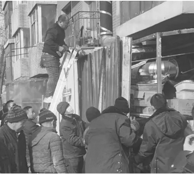
执法人员拆除违建现场 城管部门供图
