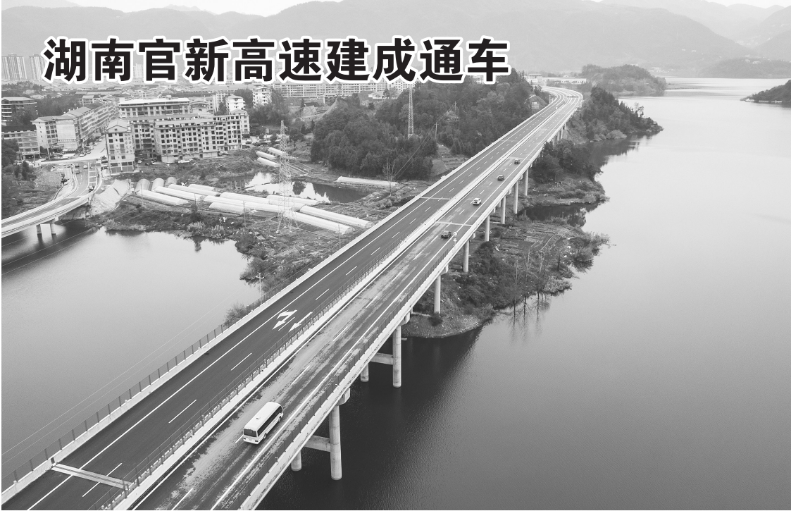
12月19日,车辆行驶在官新高速杨家湾大桥上(无人机照片)。当日,官新高速公路正式开通。官新高速起于湖南沅陵县官庄镇沐濯铺,止于新化县琅塘镇水口坑,主线全长76.581公里,路线连接湖南怀化、常德、益阳和娄底四地,共有106座桥梁、22条隧道,桥隧比高达74%。
