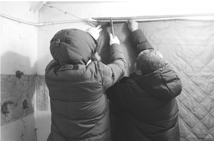
安装人员安装门帘 本组图片 城市晚报全媒体记者 陆续 摄
