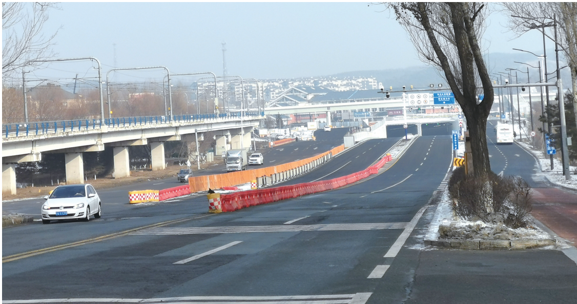
下穿隧道橙桔路附近出入口 城市晚报全媒体记者 吕闯 摄
