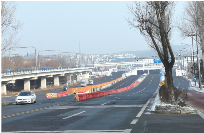
下穿隧道橙桔路附近出入口 城市晚报全媒体记者 吕闯 摄
