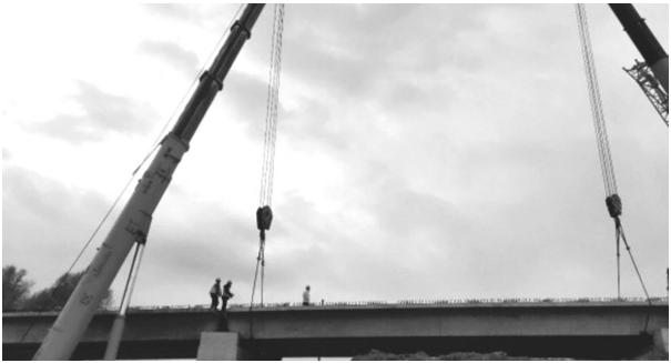
该工区桥梁下部施工结束 长环高速联合体总项目部供图
