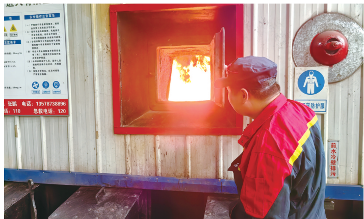
锅炉内的煤火正旺 城市晚报全媒体记者 刘佳雪 摄
