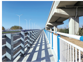
北湖大桥封闭式非机动车道
