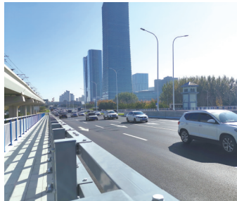
北湖大桥东侧上桥口
