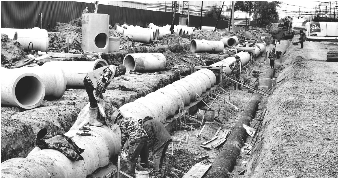
近年来,通榆县持续推进城市功能改造提升,今年投资2670.5万元,建设长青路(建设街—生态大街),该项目建成后将进一步完善城市基础配套设施,从根本上解决千万户家庭的出行问题。图为建筑工人在铺设污水管道和雨水管道。 陈宝林 摄
