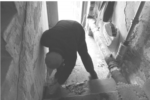
破损的台阶用水泥重新进行修复 社区供图
