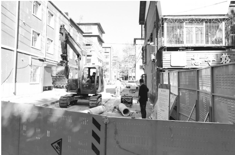
施工现场 城市晚报全媒体记者 刘佳雪 摄
