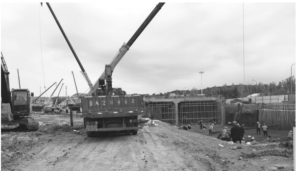
下穿隧道南侧出入口 城市晚报全媒体记者 吕闯 摄
