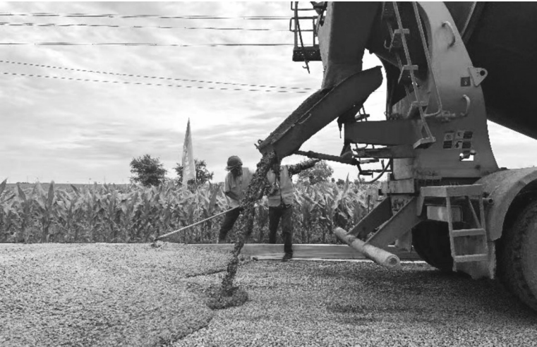
施工现场 省交通运输厅供图
