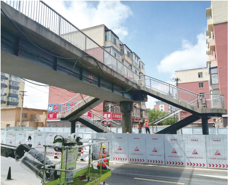
过街天桥北侧施工现场 城市晚报全媒体记者 刘佳雪 摄
