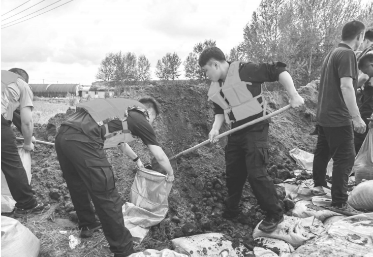
民警加固堤坝 警方供图
