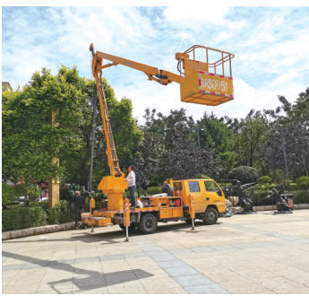
施工工人正在安装景观灯杆
