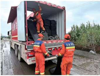
消防救援人员开展排涝清淤作业
