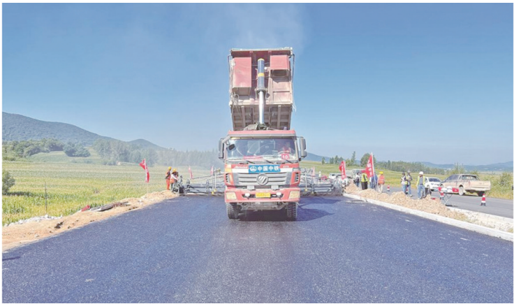
建设中的蒲烟高速公路 省交通运输厅供图
