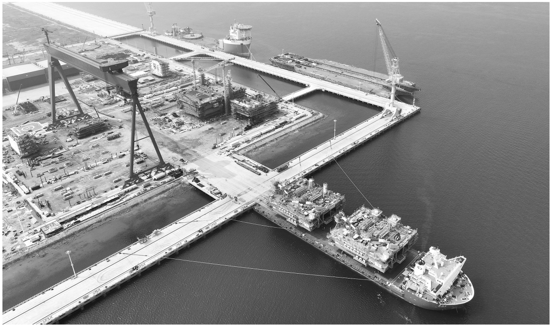
这是8月9日在天津滨海新区拍摄的渤中19-6凝析气田I期开发项目组块装船作业现场(无人机照片)。组块装船后将赴渤海西部海域,进入海上安装和联调阶段。渤中19-6凝析气田位于渤海中部海域,是中国东部第一个大型、整装、高产、特高含凝析油的千亿级立方米凝析气田。
