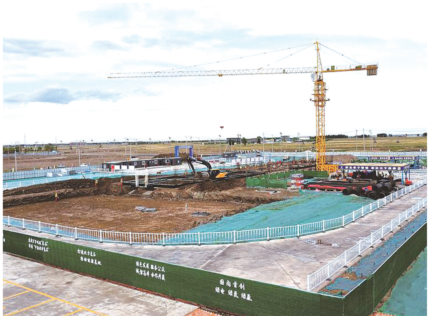
近日,作为“氢动吉林”启动项目的大安风光制绿氢合成氨一体化示范项目全面开工,该项目一期预计2024年投产,建成后可年产绿氢3.2万吨、绿氨18万吨,将有力助推我省打造“北方氢谷”。图为该项目一期工程建设现场。张野 摄
