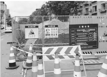
管网改造施工现场 城市晚报全媒体记者 刘佳雪 摄
