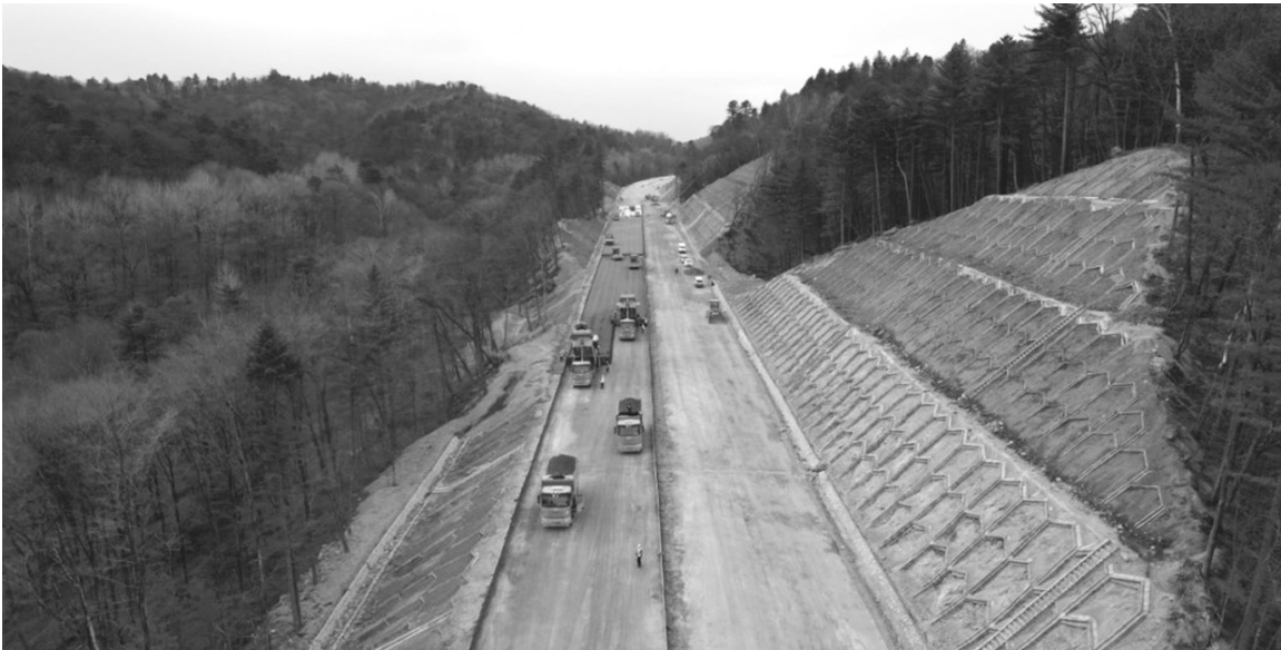
交通项目建设现场 本组图片 省交通运输厅供图
