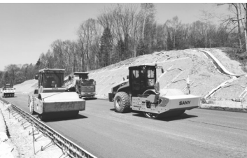
大型机械作业中
