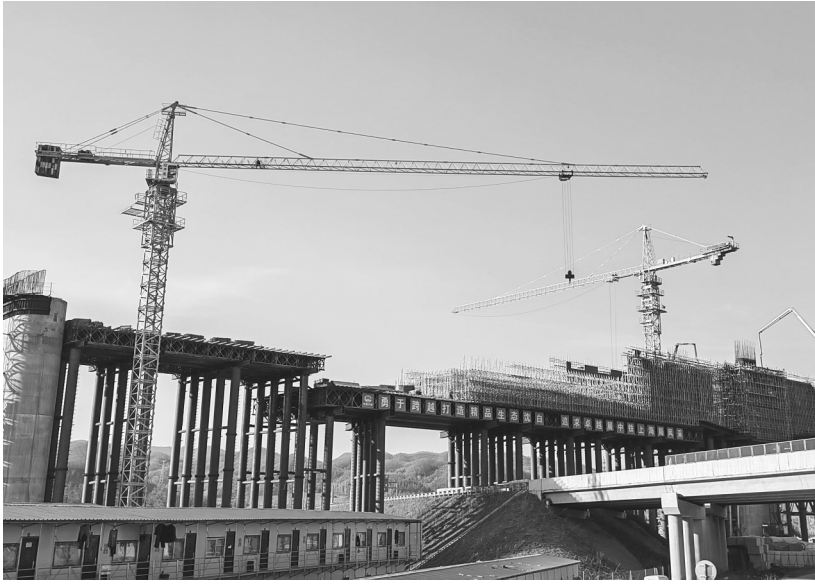
施工现场 项目部供图
