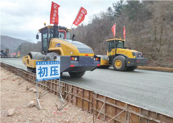
压路机完成摊铺 吉高集团供图
