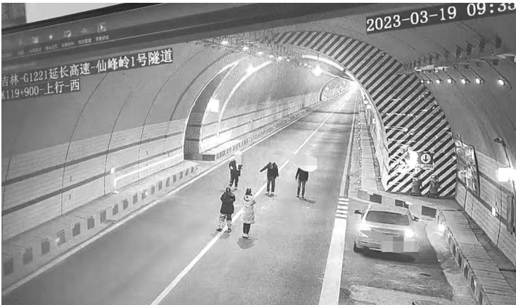
在隧道内停车拍照 警方供图
