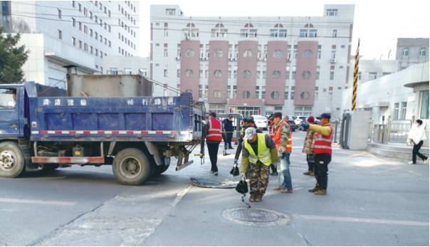
施工有序进行中 城市晚报全媒体记者 刘佳雪 摄
