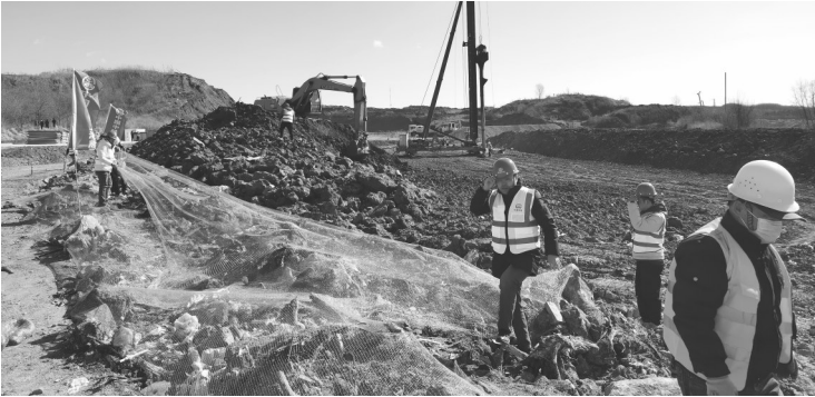
施工现场 城市晚报全媒体记者 陆续 摄
