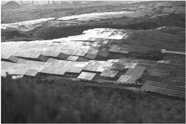
图为天骄绿能50万千瓦光伏发电项目的局部。
