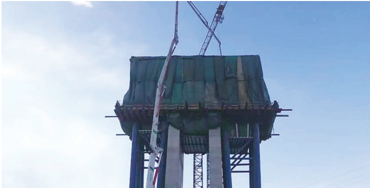
施工现场 项目部供图
