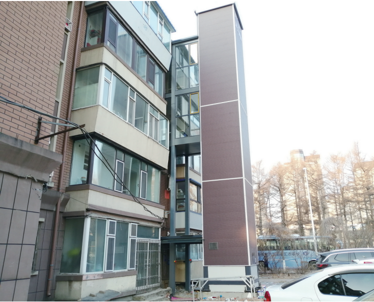
电梯基本竣工即将投入使用 城市晚报全媒体记者 刘佳雪 摄
