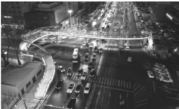
工农大路建设街天桥
