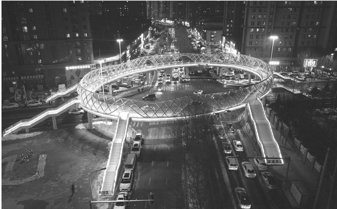
东北师大东安学校天桥 本组图片 长春市建委供图
