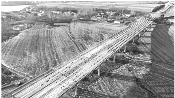
靴草大桥箱梁架设全部完成 长环高速联合体总项目部供图
