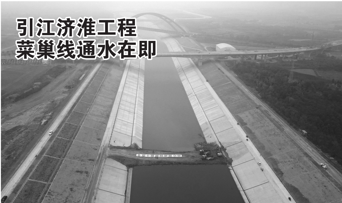
9月29日,中铁十局三建公司施工机械在引江济淮工程河道上作业(无人机照片)。近日,由中铁十局三建公司承建的引江济淮工程(安徽段)菜巢线切岭段进入最后冲刺施工阶段,为引江济淮工程顺利通航提供了保障。引江济淮工程沟通长江、淮河两大水系,是我国跨流域、跨省重大战略性水资源配置和综合利用工程。 新华社记者 刘军喜 摄
