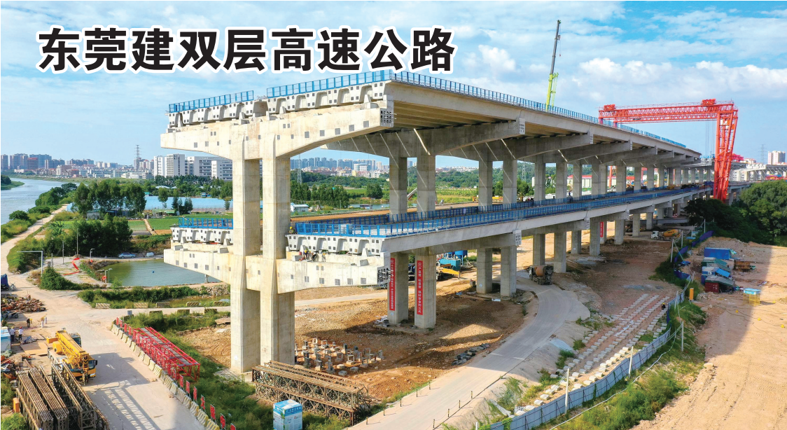
这是9月27日拍摄的莞番高速双层桥梁架施工现场(无人机照片)。
