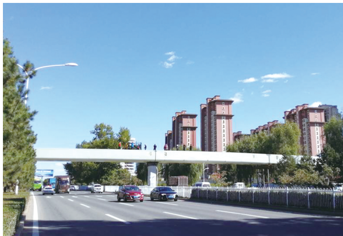
天桥施工进入收尾阶段 城市晚报全媒体记者 刘佳雪 摄
