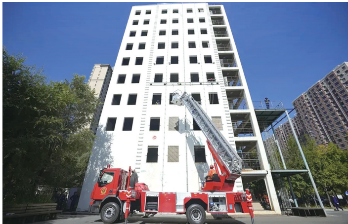
云梯车窗口转移人员 消防供图
