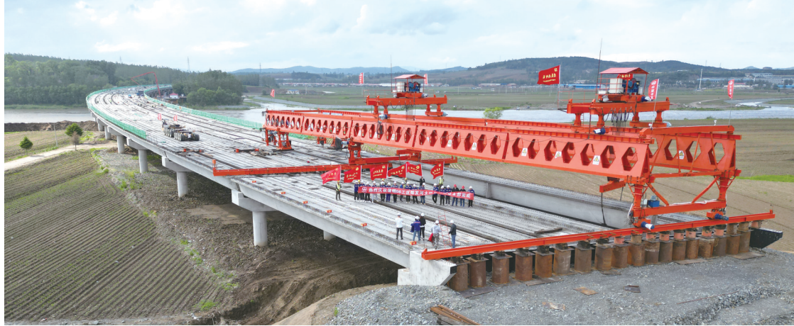
完成辉发河大桥箱梁架设
