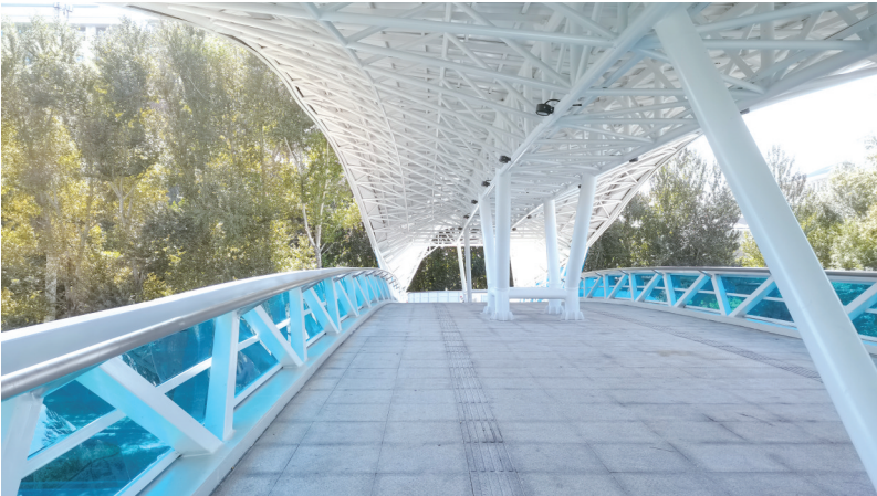
投入使用的过街天桥
