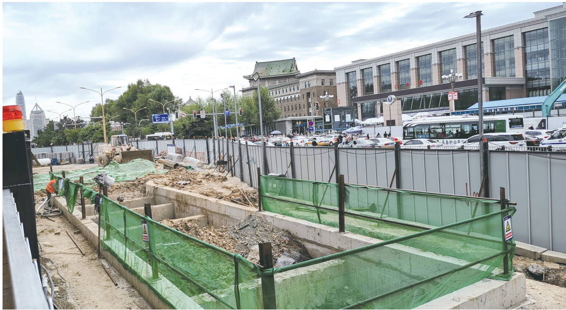
吉大一院人行过街通道施工现场 城市晚报全媒体记者 吕闯 摄
