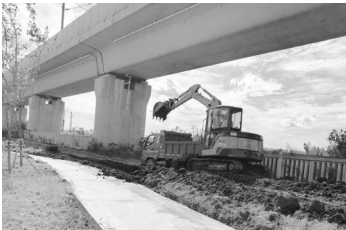
大型机械正在施工
