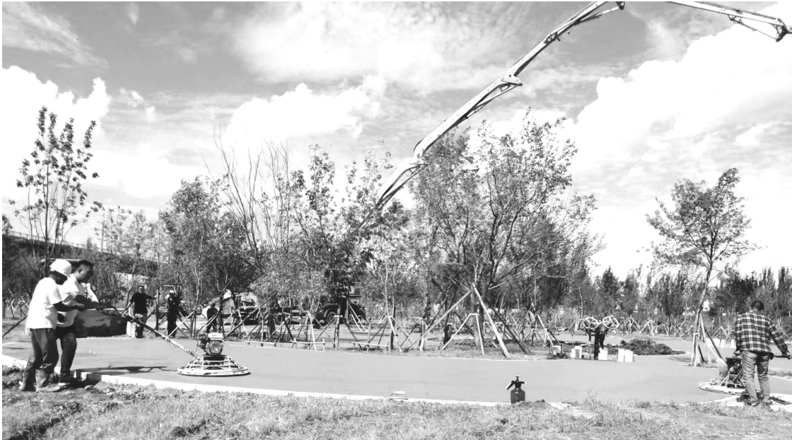
施工现场 本组图片城市晚报全媒体记者 刘佳雪
