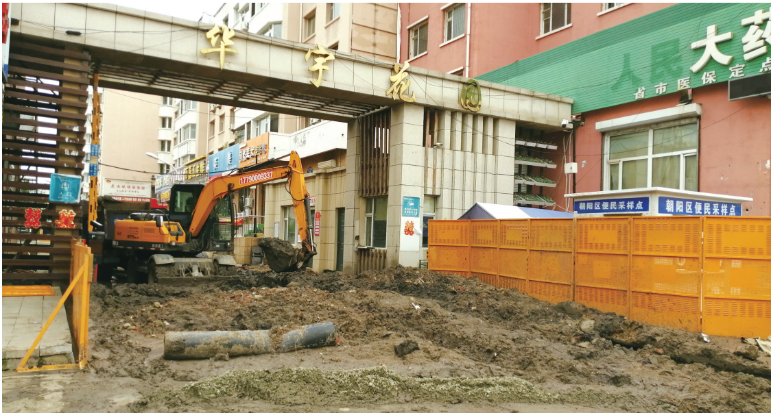
华宇花园小区正在施工
