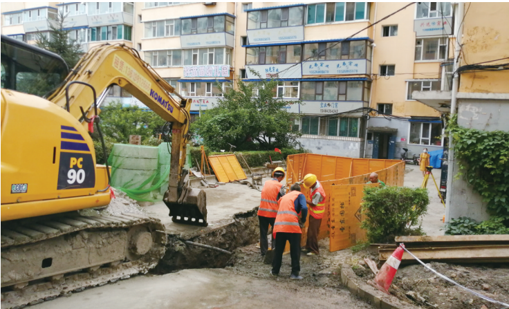
大型机械与施工人员配合作业 本组图片 城市晚报全媒体记者 刘佳雪 摄
