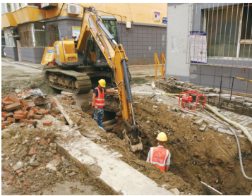
施工人员正在铺设管道
