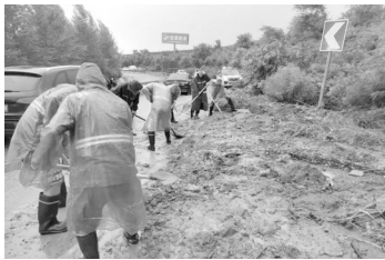
抢险人员开辟出一条临时通道
