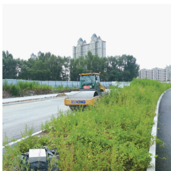
路面基础硬化基本完成
