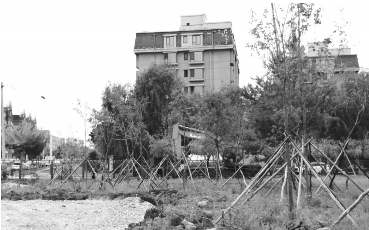
大型机械正在作业 城市晚报全媒体记者 刘佳雪 摄
