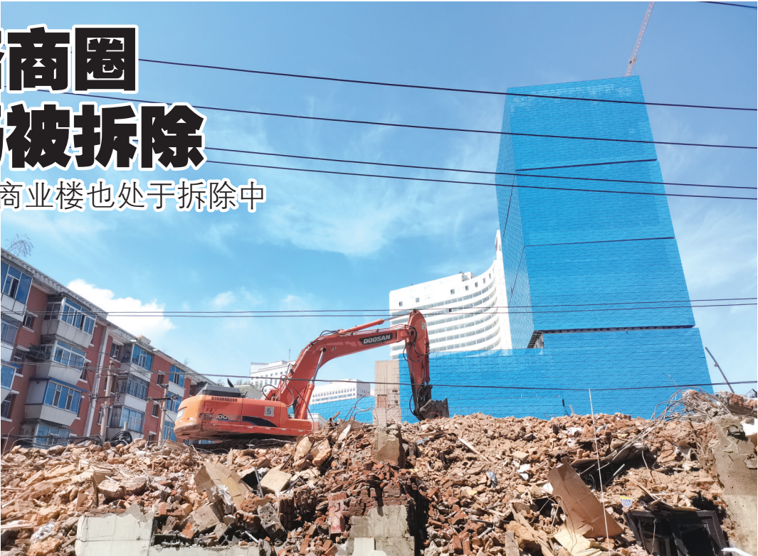
拆除中的原东方时空商场 本组图片 城市晚报全媒体记者 陆续 摄
