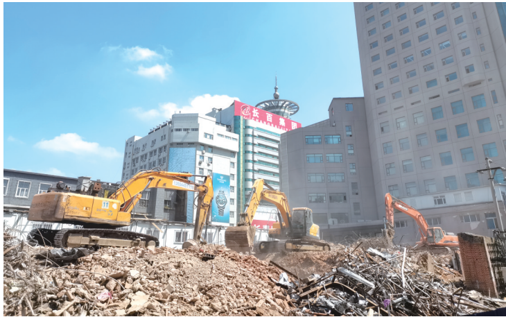
三台钩机正在原东方时空商场处施工作业
