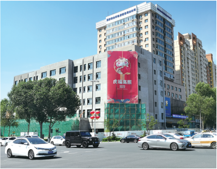
装修改造中的“友谊商店” 城市晚报全媒体记者 陆续 摄
